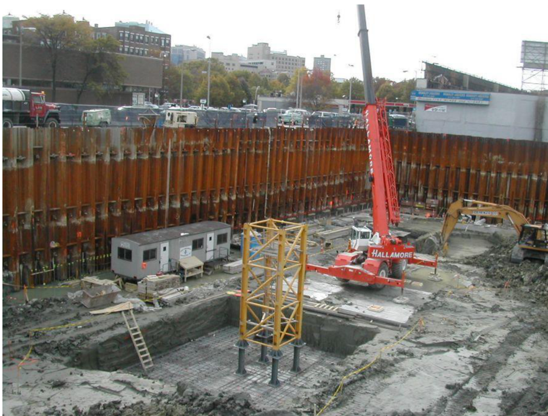
Obr. 2-9: Zajištění stavební jámy štětovicovými stěnami [18]
