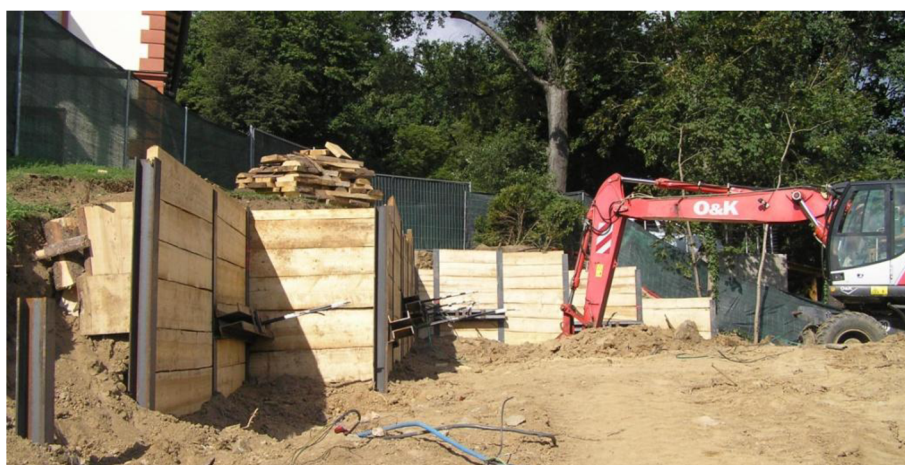
Obr. 3-25: První kotevní úroveň s předpínanými kotvami [Keller]
