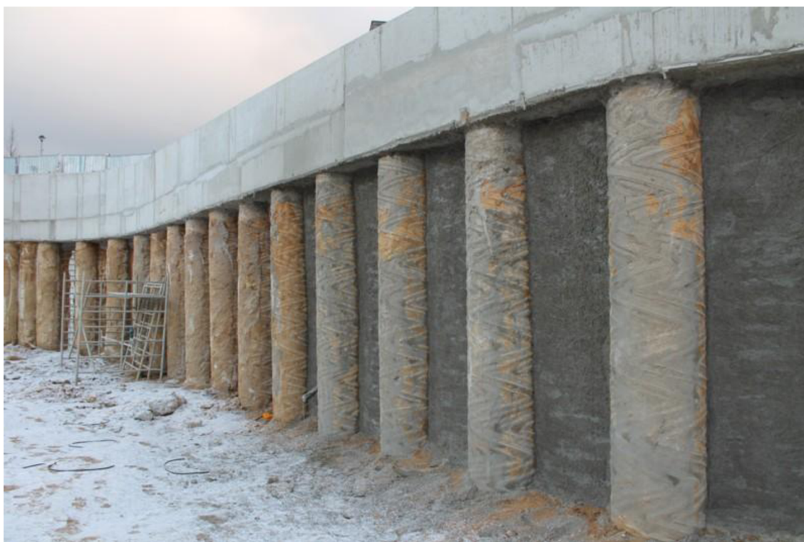
Obr. 2-6: Pilotová stěna s velkou osovou vzdáleností pilot [13]
