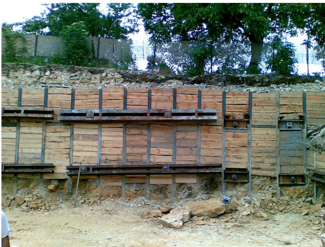
Obr. 2-5: Stěna výkopu zajištěna mikrozáporovým pažením [10]
