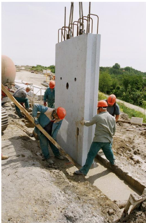
Obr. 2-7: Osazování prefabrikátu do rýhy vyplněné samotvrdnoucí pažící suspenzí [14]
