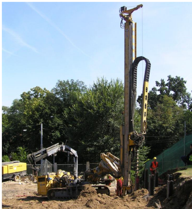
Obr. 3-24: Vrtání maloprofilových vrtů pro osazení zápor [Keller]
