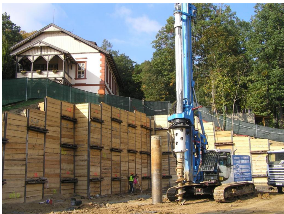
Obr. 3-26: Pažící konstrukce ve finální fázi [Keller]
