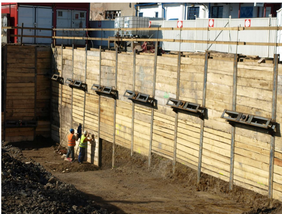
Obr. 2-4: Stěna stavební jámy zajištěna záporovým pažením [7]
