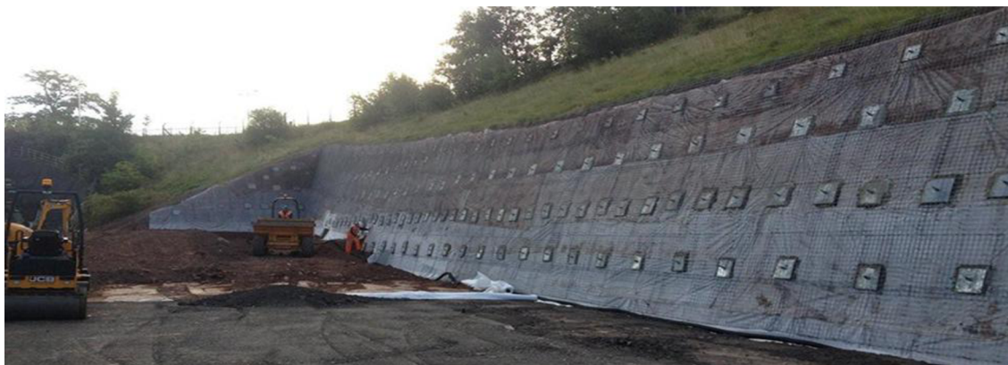
Obr. 2-3: Stěna stavební jámy zajištěna hřebíkováním [6]
