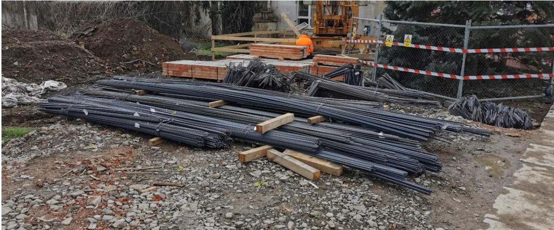
Obrázek 126 - Skladování výztuže [autor]
