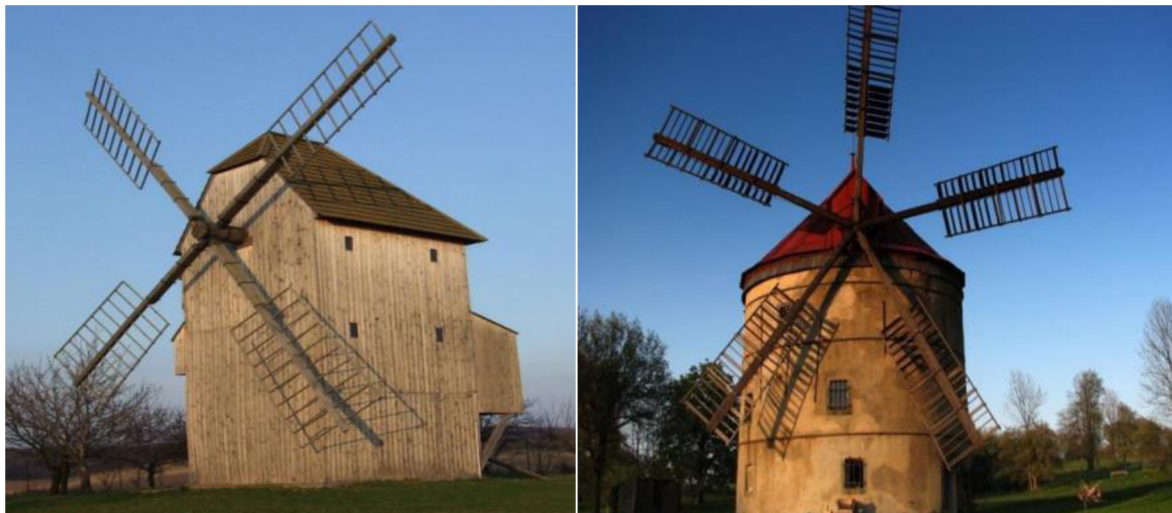
Obrázek 3: sloupový mlýn Starý Poddvorov (vlevo)
