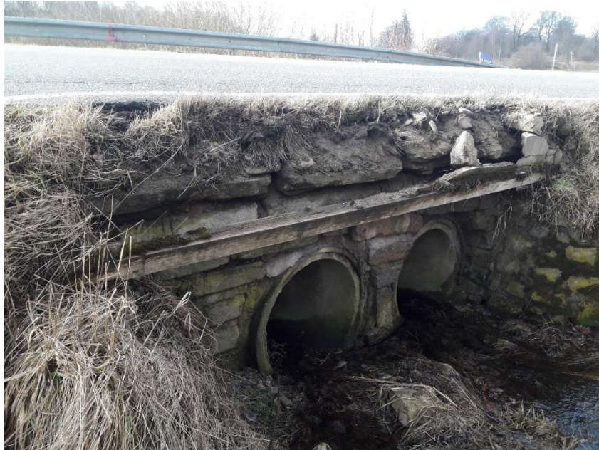
Deformace mostu přetížením (Batelov)
