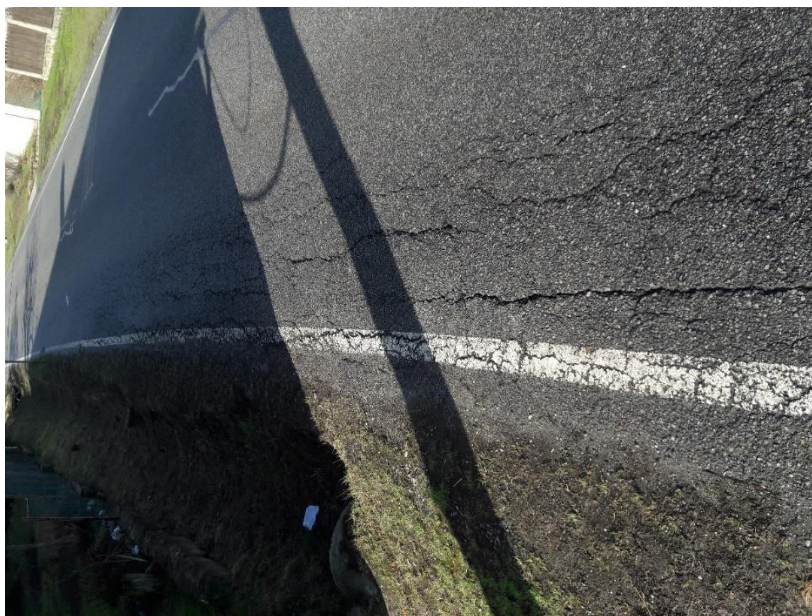
Deformace silnice přetížením (Bezděčín)
