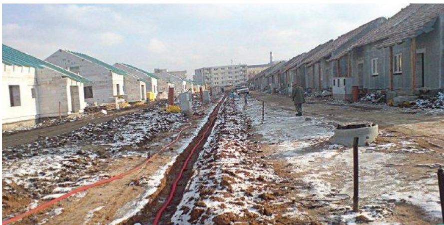
Obr. č. 5: Veřejné telekomunikační vedení ( http://www.czechbone.net )
