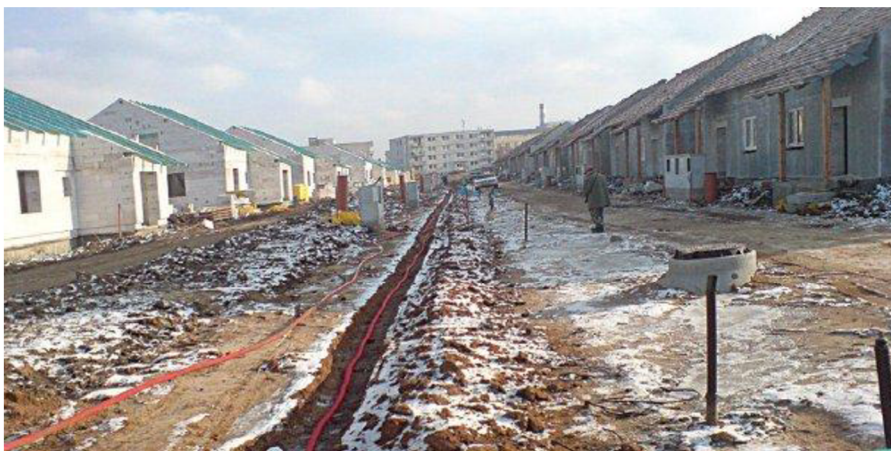
Obr. č. 5: Veřejné telekomunikační vedení ( http://www.czechbone.net )
