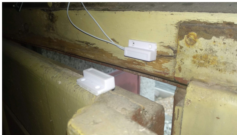
Obrázek 4.4: Detail magnetického čidla na zárubni a magnetu na dveřích v rozpojeném stavu.
