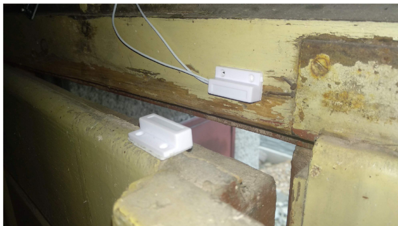
Obrázek 4.4: Detail magnetického čidla na obrubni a magnetu na dveřích v rozpojeném stavu.
