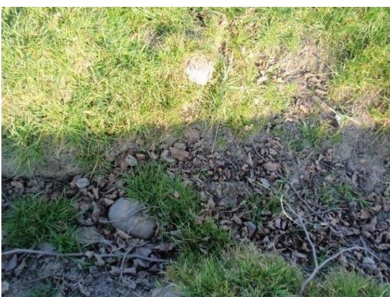
Foto 7: Plastový mezník číslo 1250-3119, který určuje jak hranu odvodňovací příkopu, tak hranici pozemku.
