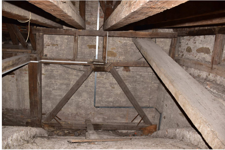
Obr. 9 — Podpůrná konstrukce u vstupní věže
