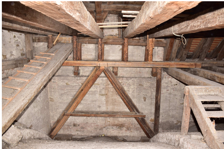
Obr. 10 — Podpůrné konstrukce u severní věže
