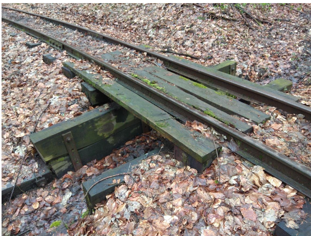
Foto č. 4 Mostek Mladějovské úzkorozchodné dráhy u štoly František Salesius (Kostíková, 2021)
