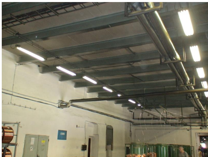
Obrázek 7. Pohled na stropní nosníky
