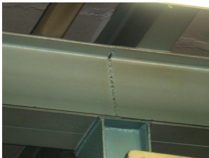
Obrázek 6. Detail napojení sloupu a průvlaku
