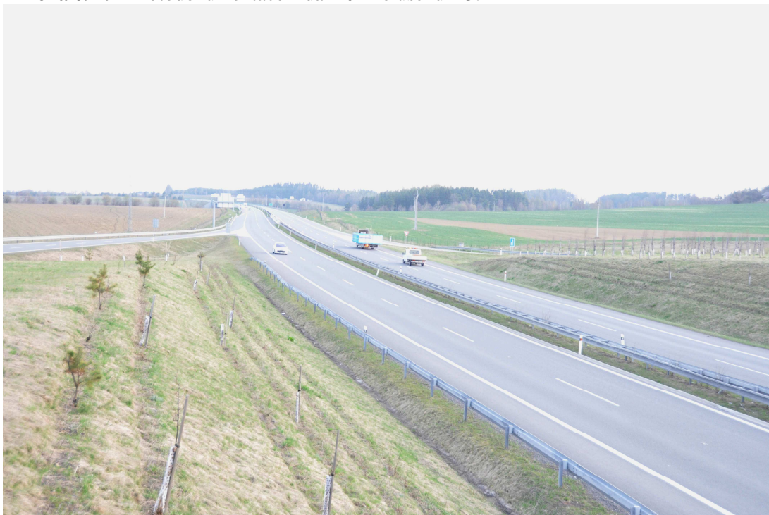
Pohled na krajinu v okolí dálnice D3 z mostu u obce Chotoviny ve směru na Prahu.
