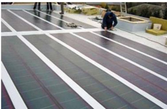
Obrázek 32 Instalace tenkovrstvého fotovoltaického panelu a schéma na panelovém domě (30)
