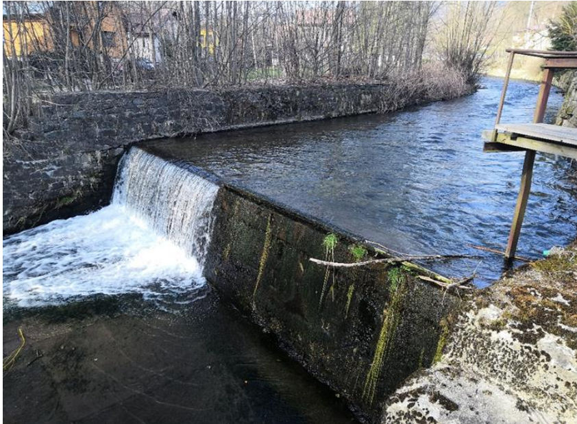
Obrázek 8: Jez a místo plánovaného rybího přechodu
