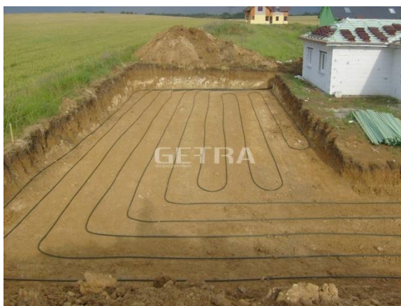
Obr. 10 Pokládka plošného kolektoru – skrývka
