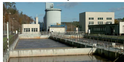
Obrázek 2: Čistírna odpadních vod
