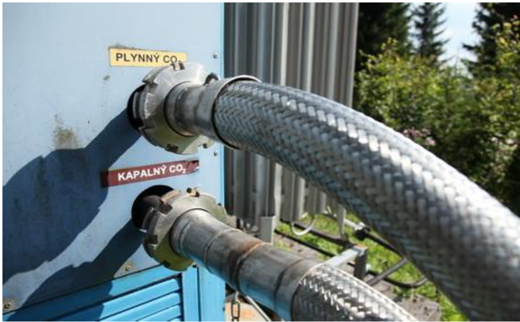
Obr. 14 Přívod CO 2 do lamelových sfér
