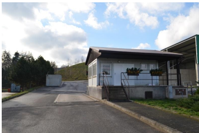
Obrázek 9: Manipulační prostor – provozní budova, vrátnice, váha
