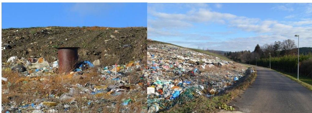
Obrázek 10: Jímací studna a komunikace okolo skládky (zdroj: autorka)
