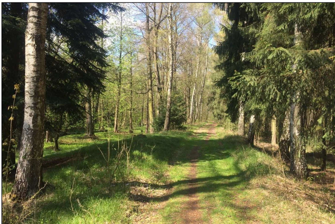
Obr. 24: Bývalá hráz zaniklého Svinarského rybníka. Vpravo pod hrází býval rybník Svinarský a vlevo začínal rybník Na Obci (nazývaný i „Nový“).
