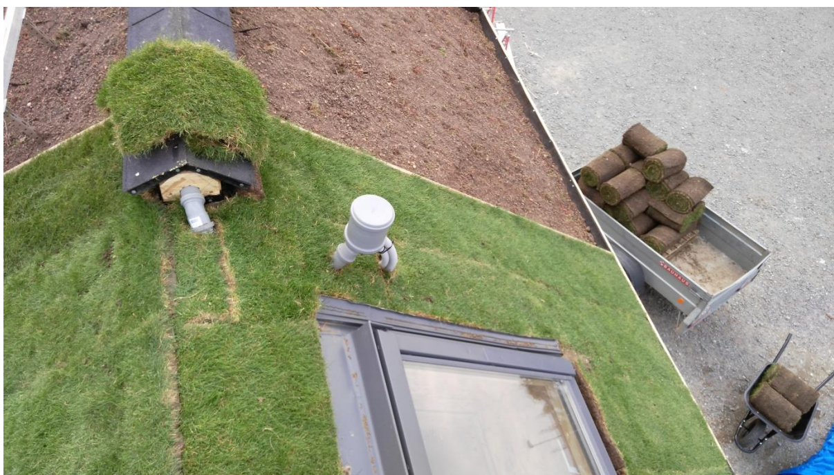
Obr. 31 Provádění středové sekce vegetace.
