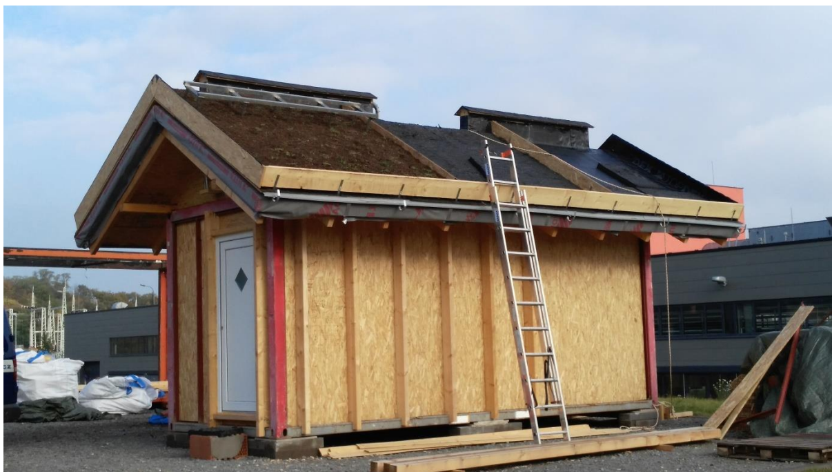
Obr. 30 Pohled po ukončení první sekce vegetace.
