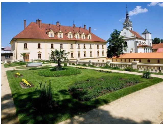
Obr. 6 Unikátní střešní zahrada na střeše bývalé konírny zámku v Lipníku nad Bečvou podle [9]
