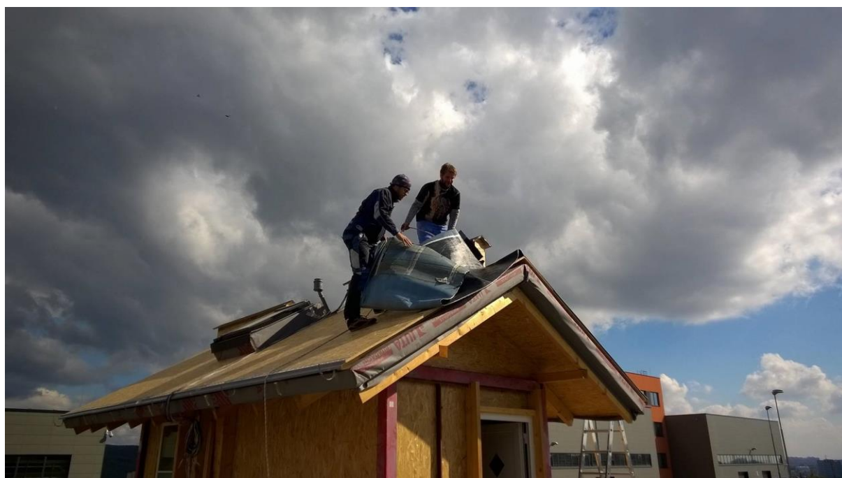
Obr. 29 Provádění hydroizolace.
