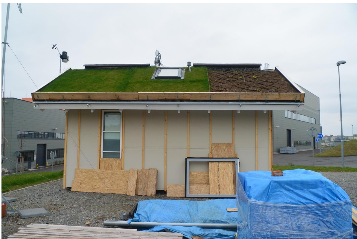
Obr. 33 Provádění opláštění domku.
