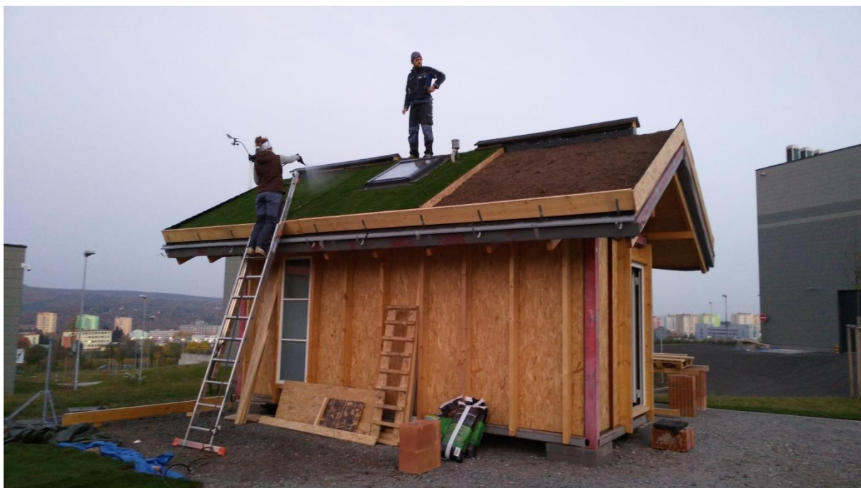
Obr. 32 První zavlažování vegetační střechy.
