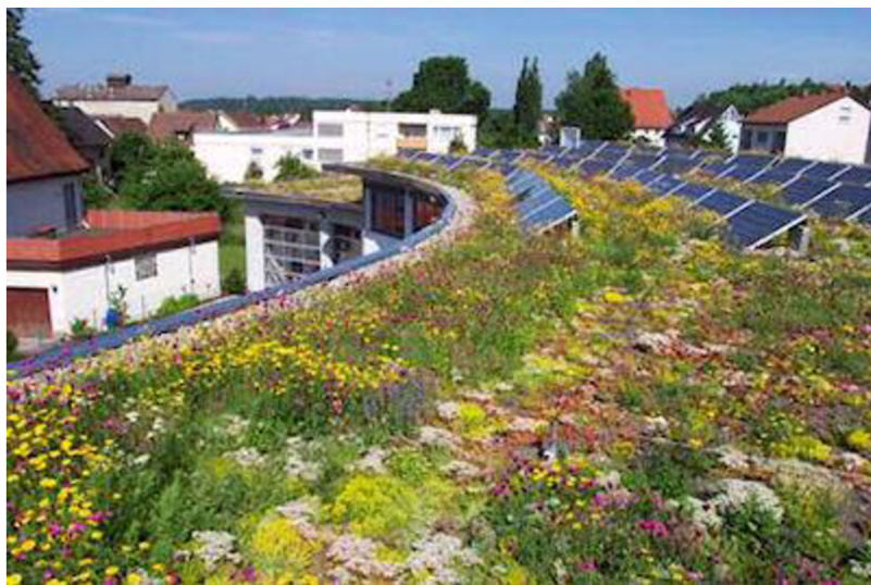
Obr. 9 Příklad extenzivní střechy podle [6]
