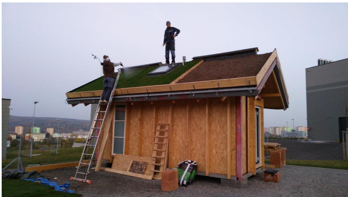
Obr. 32 První zavlažování vegetační střechy.
