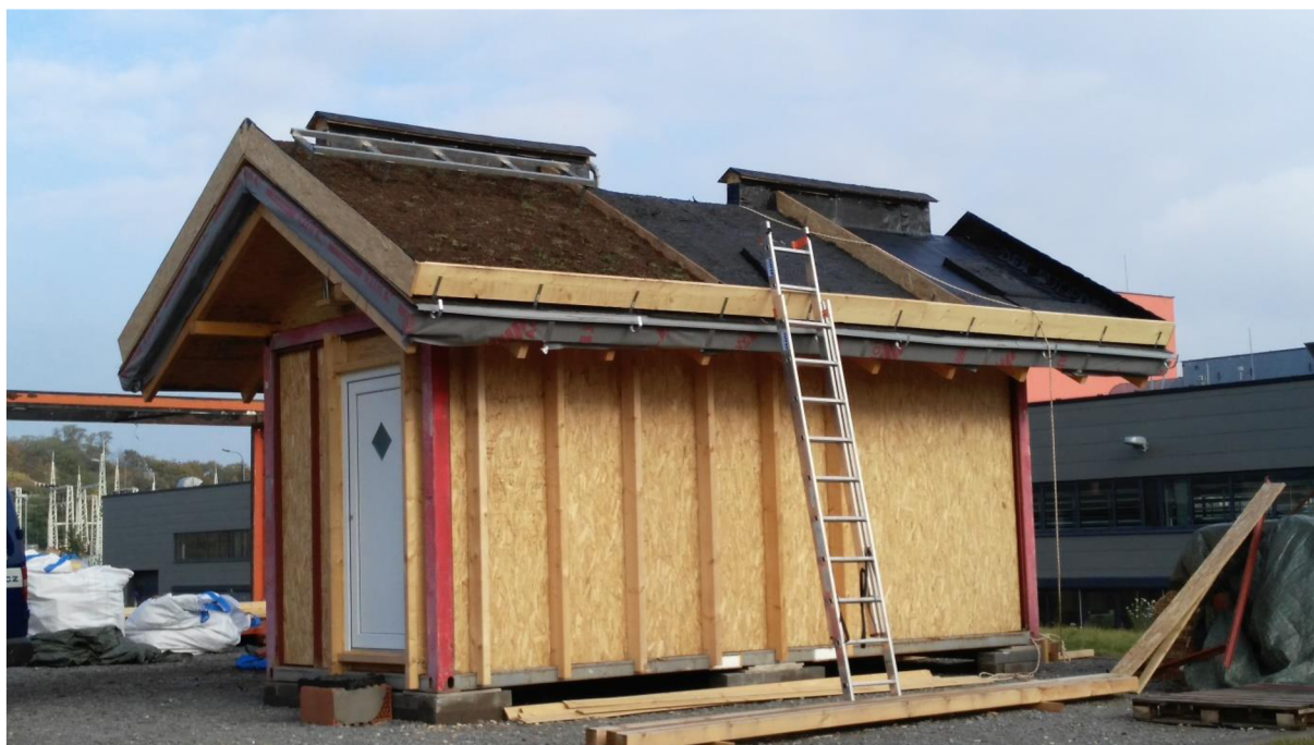
Obr. 30 Pohled po ukončení první sekce vegetace.
