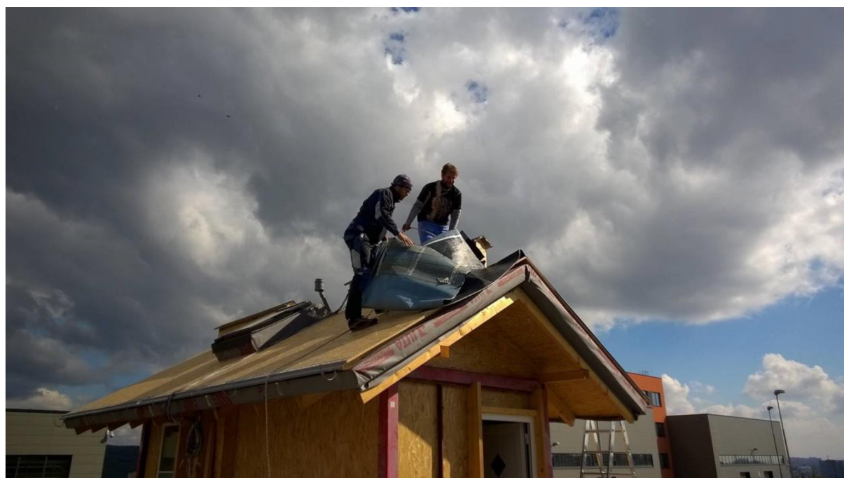
Obr. 29 Provádění hydroizolace.
