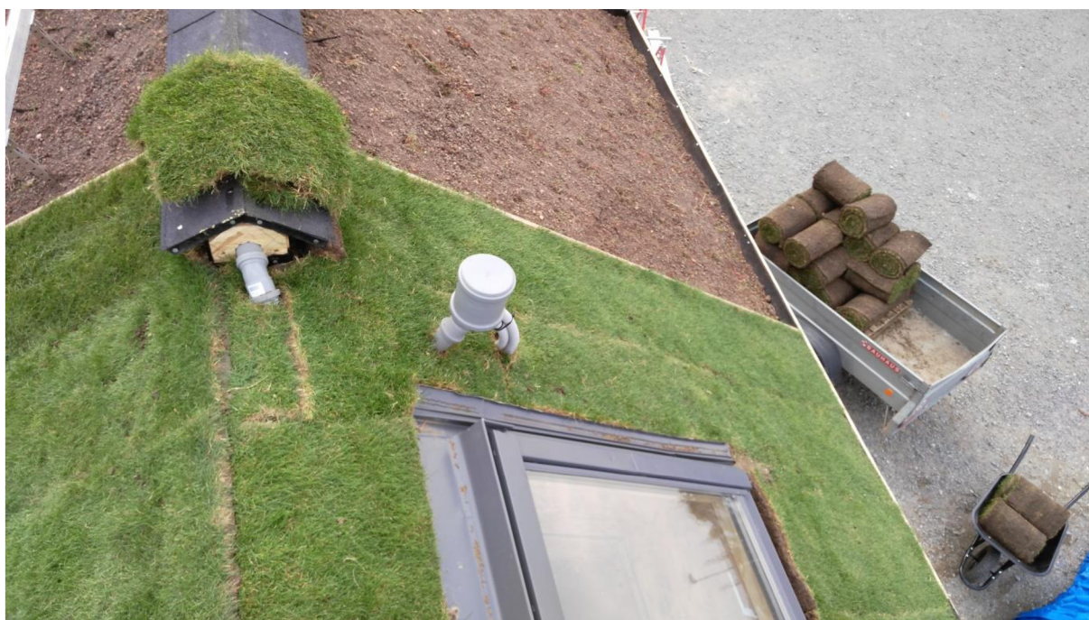
Obr. 31 Provádění středové sekce vegetace.
