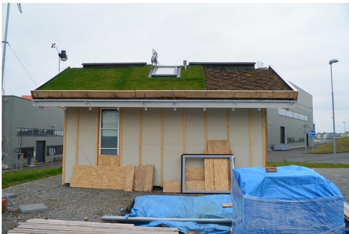
Obr. 33 Provádění opláštění domku.
