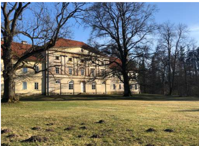
Obrázek 6: Čelní pohled na hosp. budovy (autorka práce)
