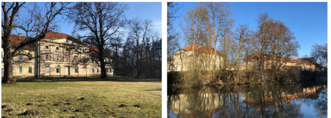
Obrázek 6: Cestní pohled na hosp. budovy (autorů práce)
