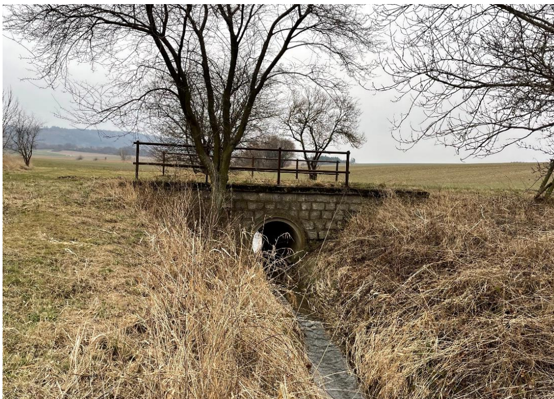
Obrázek č. 14- Most s propustkem na VPC01 (Vlastní fotografie, 2022)
