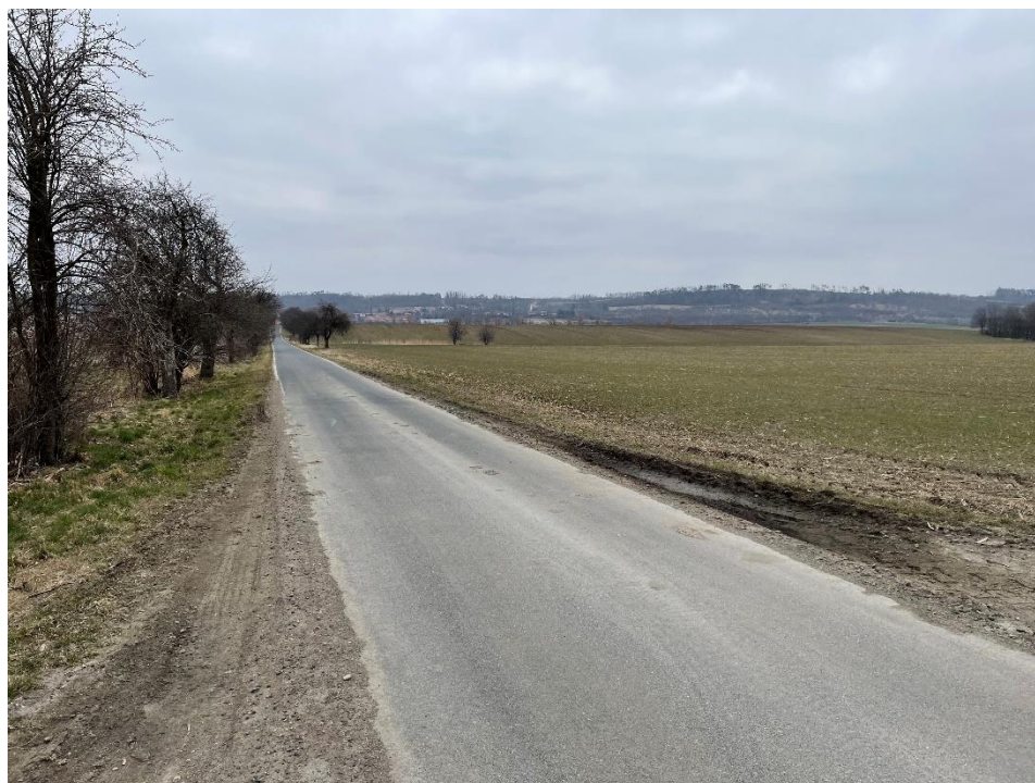
Obrázek č.12- Silnice III/33729 (Vlastní fotografie, 2022)
