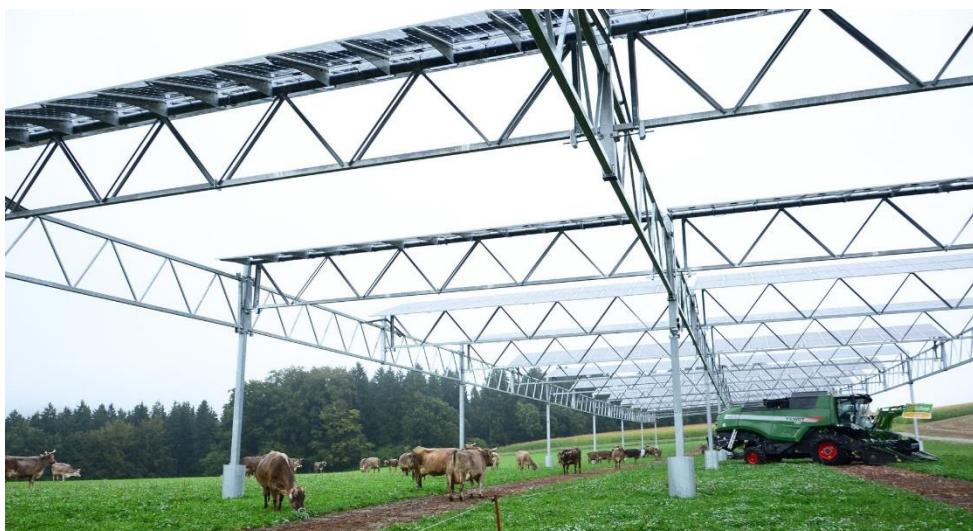
Obr. 10 Umístění FVE panelů nad zemědělskou plochu
