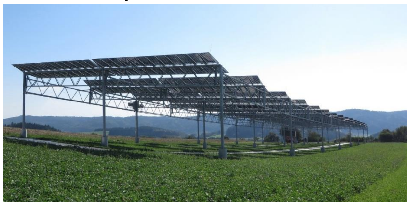
Obr. 9 Umístění FVE panelů nad zemědělskou plochu
