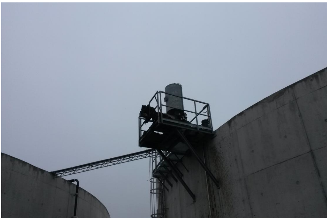
Obrázek 4 – Separace digestátu. Do nádrže (nahore) je přiváděn digestát. Lisováním se odloučí fugát a separát. Fugát je odváděn do jímky, separát na skládku.
