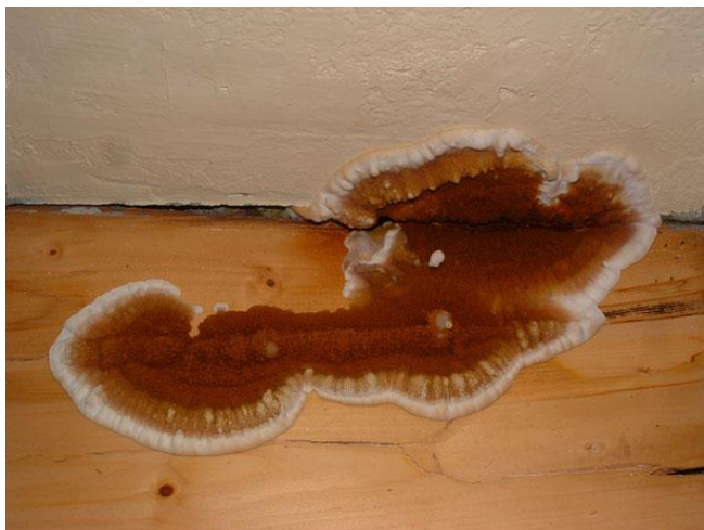
Obr. 10: Dřevomorka domácí ( Serpula lacrymans )
