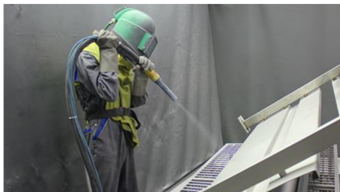
Obr. 24 Tryskání ocelové konstrukce [16]
