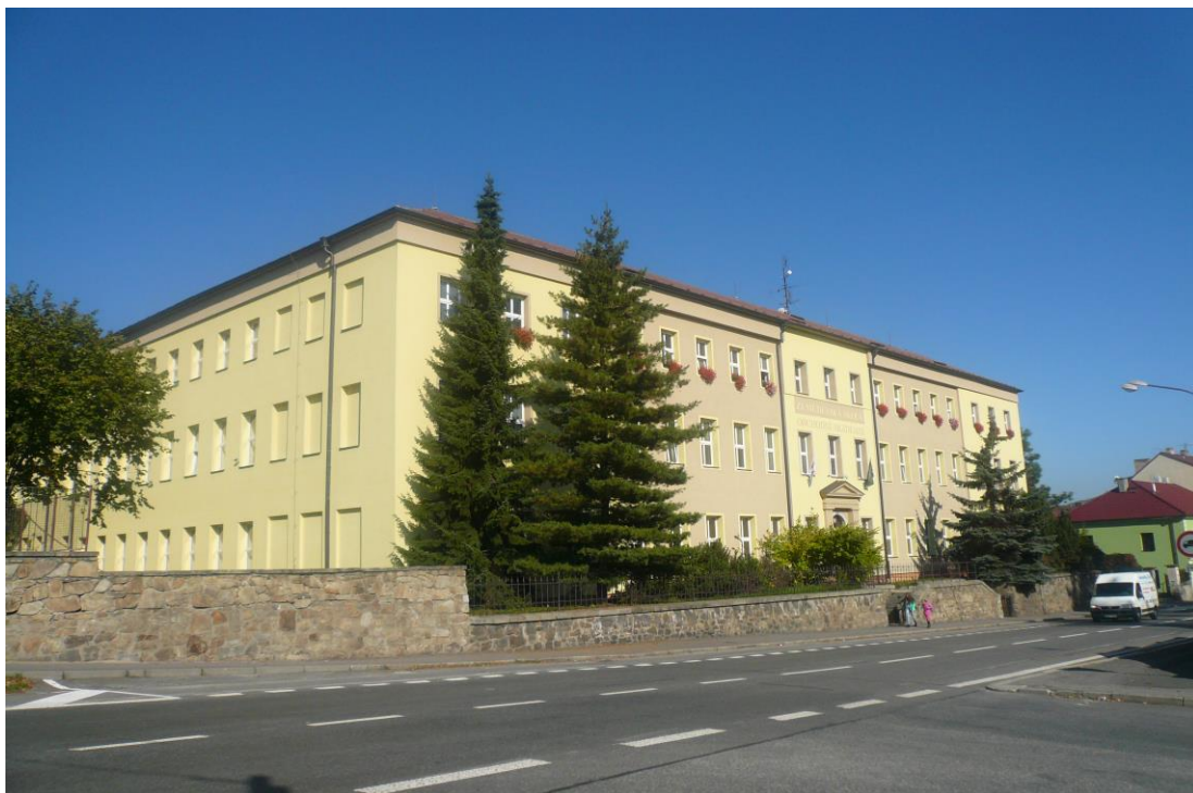
Hlavní budova před rekonstrukcí
