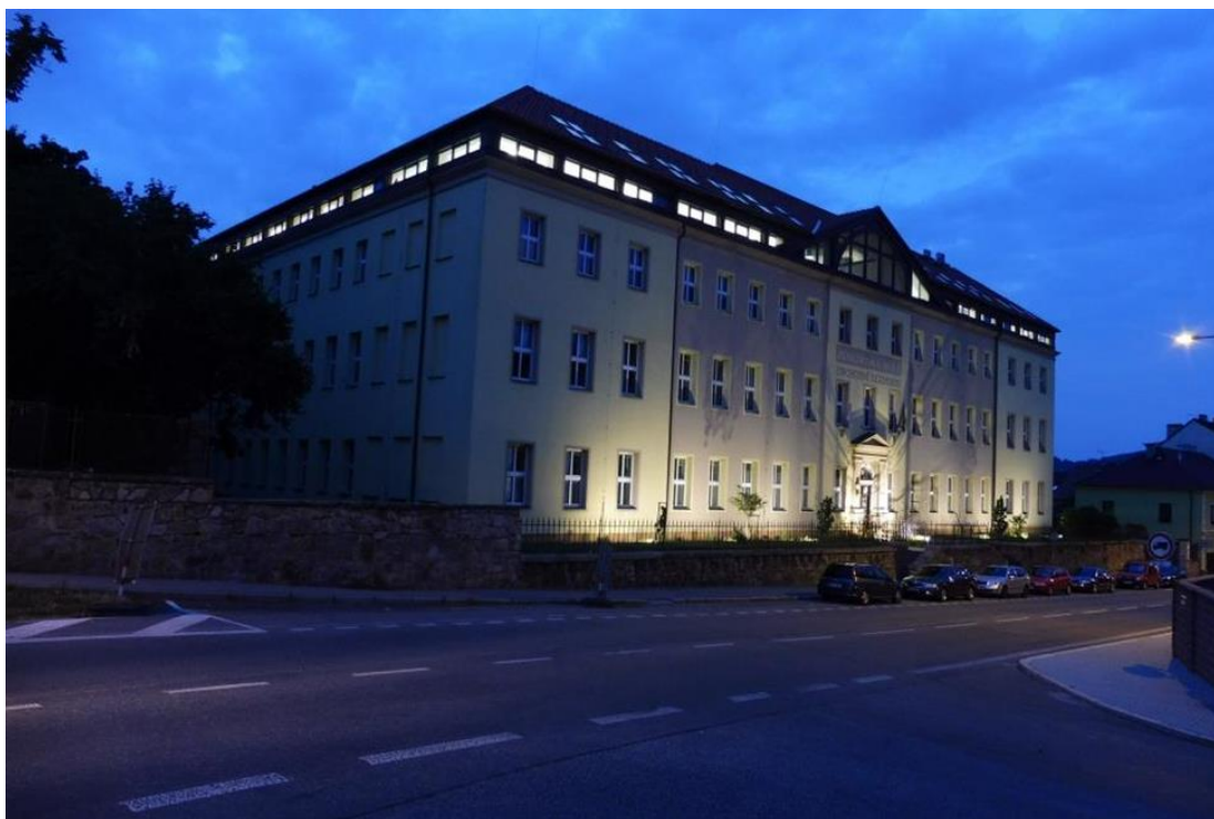
Hlavní budova po rekonstrukci včetně půdní vestavby
