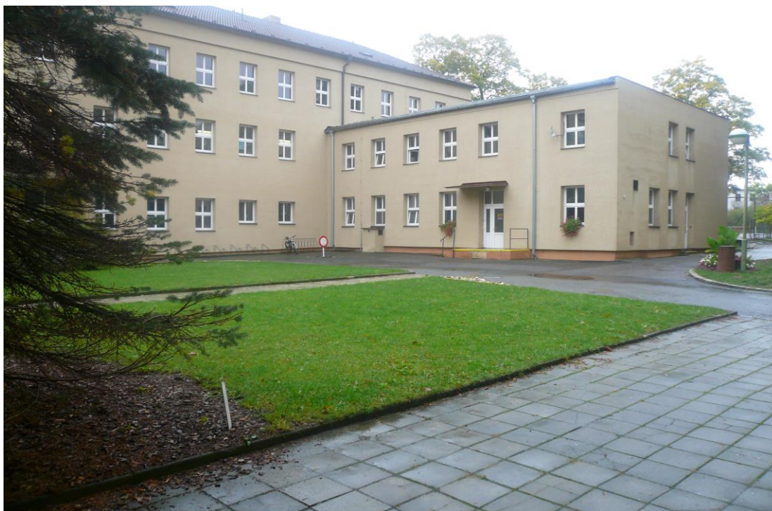
Nádvoří před rekonstrukcí
