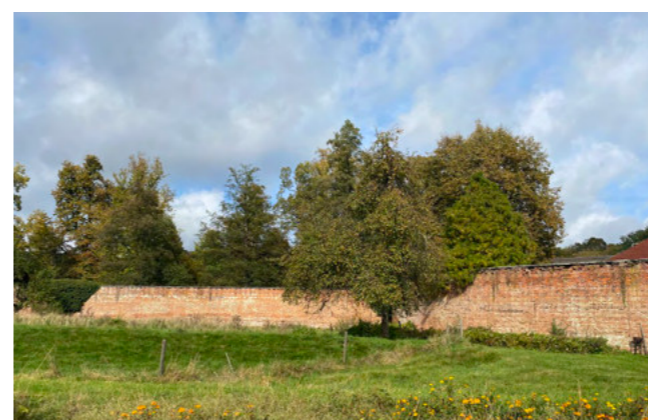
Obr. 4.39: Severovýchodní část zdi (Foto autorky)
