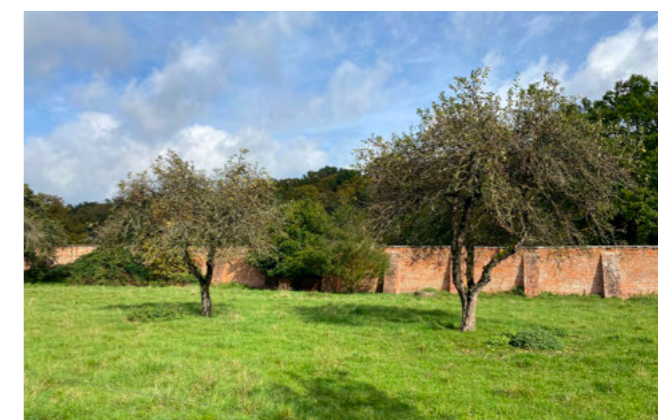
Obr. 4.40: Východní část zdi (Foto autorky)
