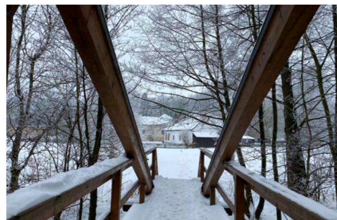
Obr. 4.16: Žernovská lávka (Foto autorky)
