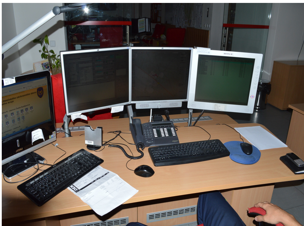
Obrázek č. 21: Pracoviště TCTV 112.
