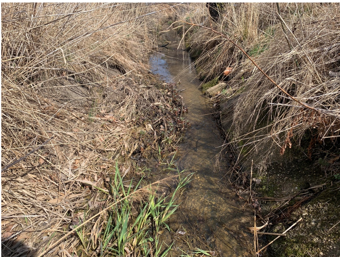
Obrázek 35: Koryto toku v úseku 7 (zdroj: vlastní)
