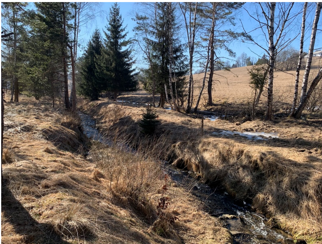
Obrázek 27: Koryto toku v úseku 5 (zdroj: vlastní)
