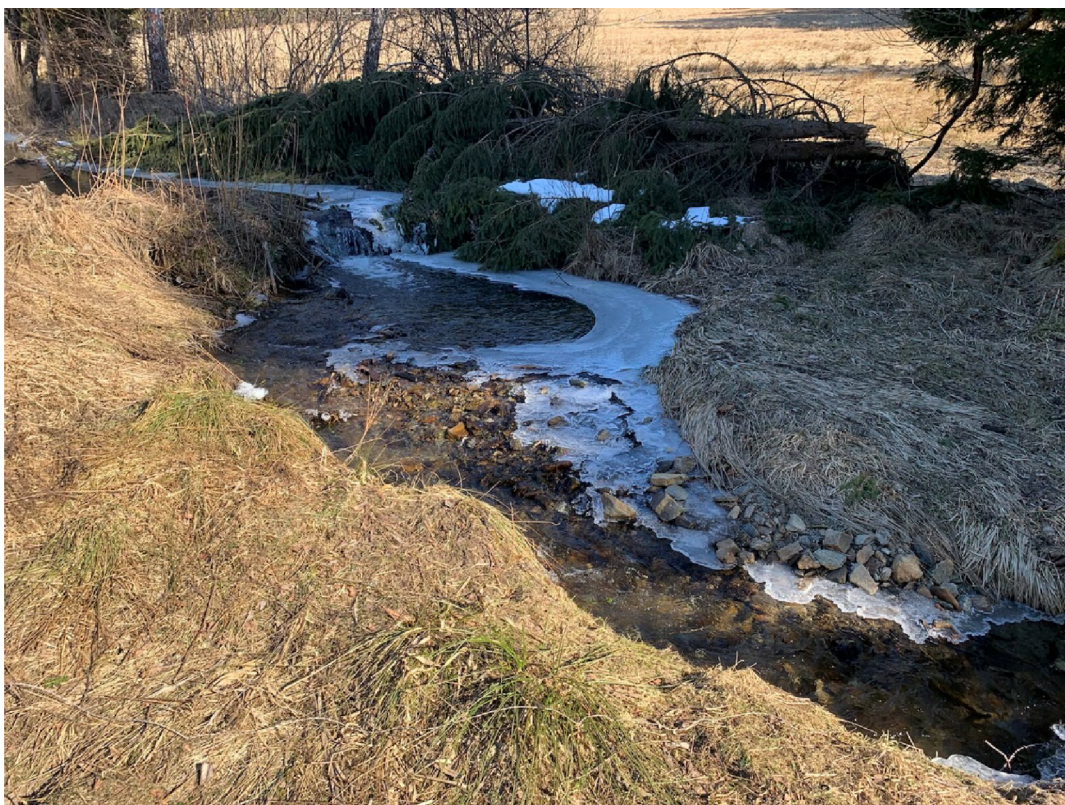
Obrázek 28: Koryto toku v úseku 5 - migrační překážka (zdroj: vlastní)
