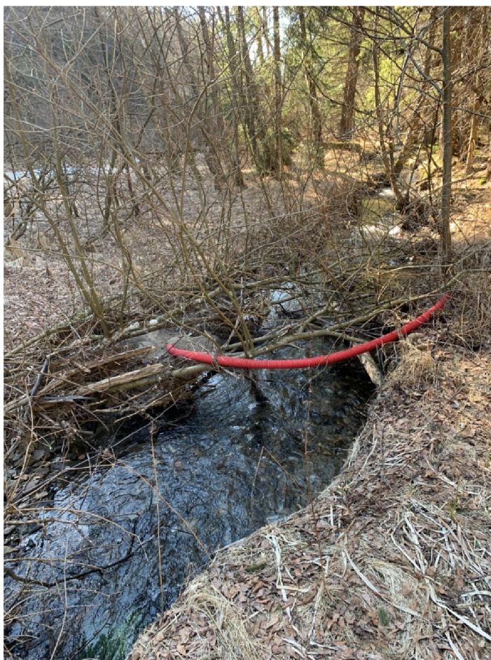
Obrázek 20: Koryto toku v úseku 3 (zdroj: vlastní)
