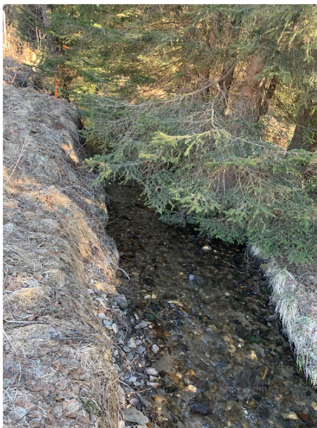
Obrázek 18: Koryto toku v úseku 2 (zdroj: vlastní)
