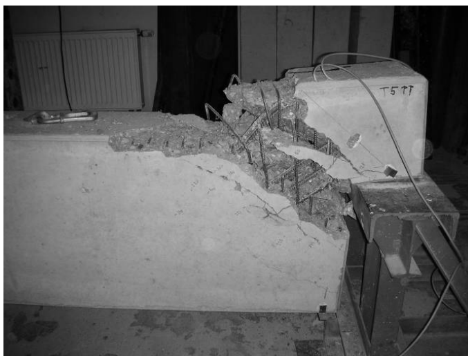
Obr. 6.28 Porušení zhlaví A2
