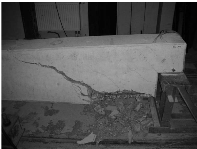
Obr. 6.27 Porušení zhlaví E
