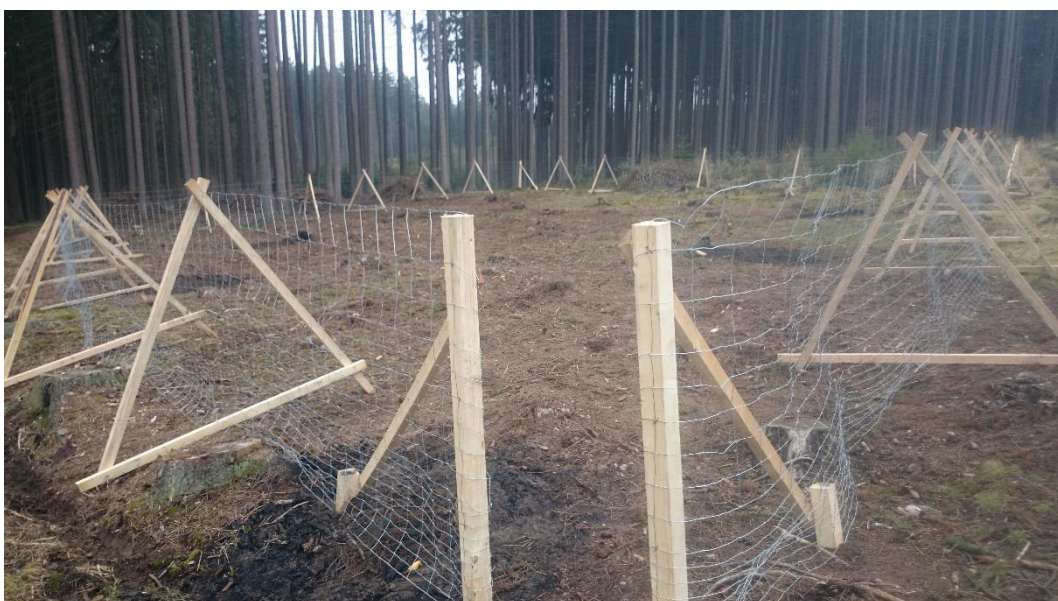
Příloha č. 12: Výstavba oplocenky
