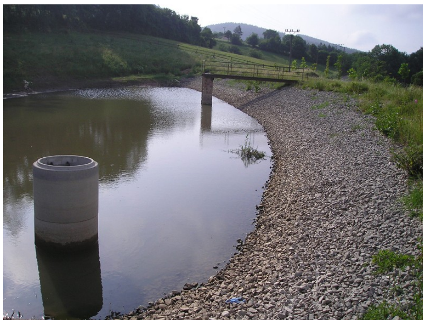
Obr. č. 19 - Návodní líc hráže s opevněním, výpustné zařízení (požerák) a kruhová jámka pro odběr požární vody - Průtočný rybník Babiny II
