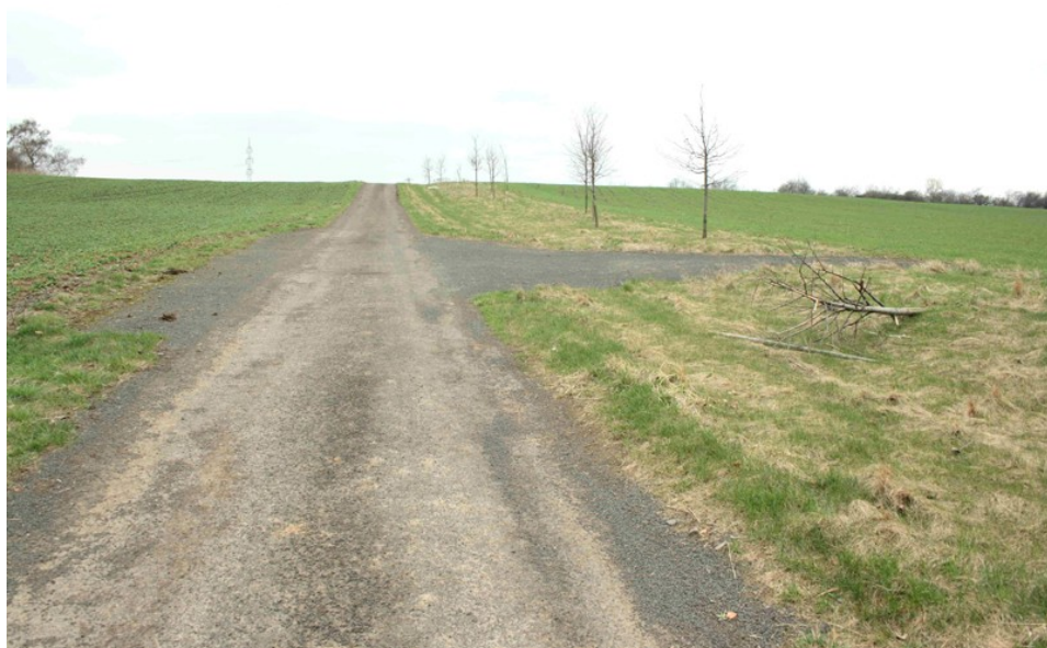
Obr. č. 16 - Protierozní průleh LV 1 - C - hospodářský sjezd situovaný napříč průlehem ze stejnojmenné souběžné polní cesty
