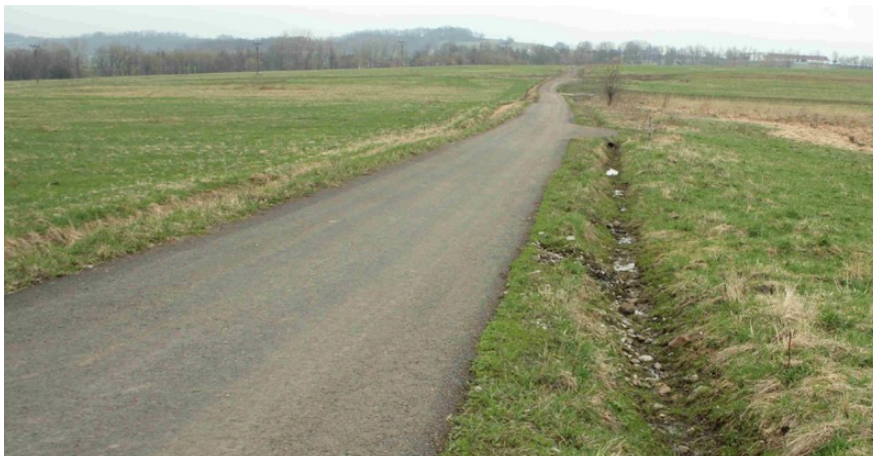
Obr. č. 12 - Celkový pohled na počáteční úsek polní cesty s pravostranným odvodňovacím příkopem - polní cesta HPC 1, k.ú. Arnultovice u Lučního Chvojna
