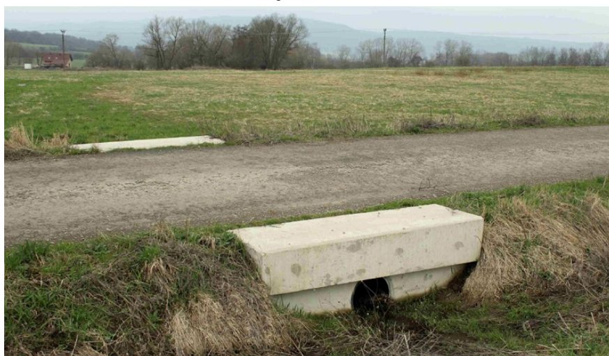
Obr. č. 13 - Příčný propustek DN 400 s betonovými čely v km 0,210 - polní cesta HPC 1, k.ú. Arnultovice u Lučního Chvojna
