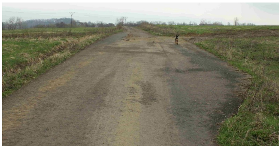
Obr. č. 14 - Pravostranná výhybna v km 0,302 - polní cesta HPC 1, k.ú. Arnultovice u Lučního Chvojna
