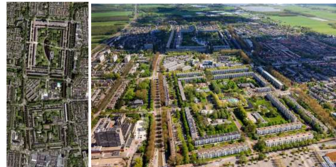
Obr. 11 Celkový pohled na obytnou čtvrť obdélníkového tvaru Zdroj: vaderarch.wixsite.com
