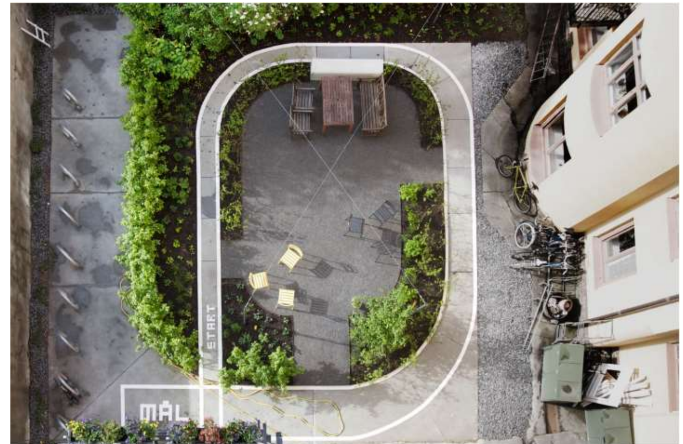
Obr. 1 Závodní dráha ve tvaru zaobleného čtverce z monolitického betonu Zdroj: http://manmadeland.de
