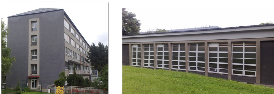
Obrázek č. 16: Základní škola Vrchlického před rekonstrukcí
