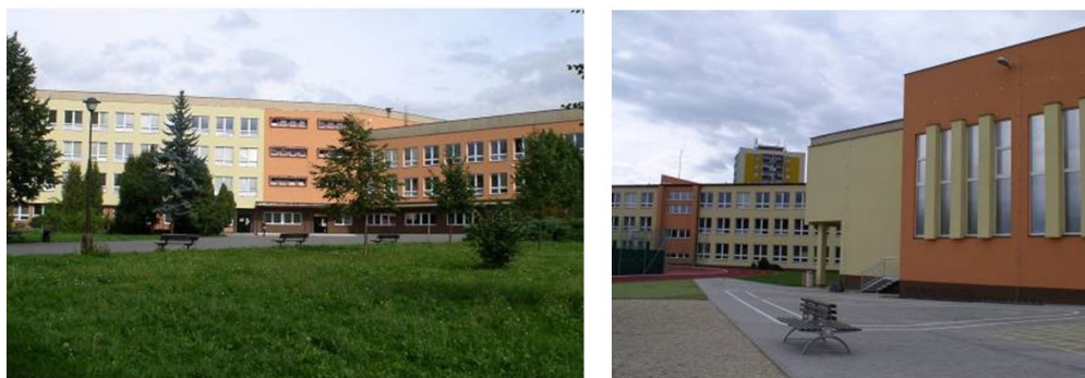
Obrázek č. 6: Základní škola Šumavská po rekonstrukci
