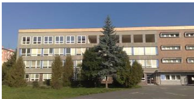
Obrázek č. 5: Základní škola Šumavská před rekonstrukcí
