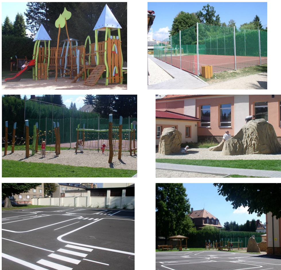
Obrázek č. 10: Zrekonstruované hřiště u Komunitního centra
