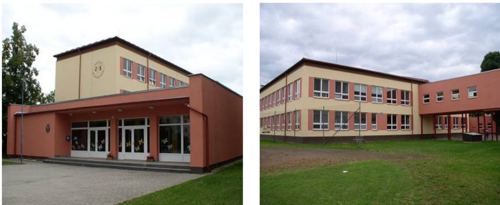
Obrázek č. 4: Základní škola Dr.E.Beneše po rekonstrukci
