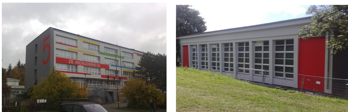
Obrázek č. 17: Základní škola Vrchlického po rekonstrukci
