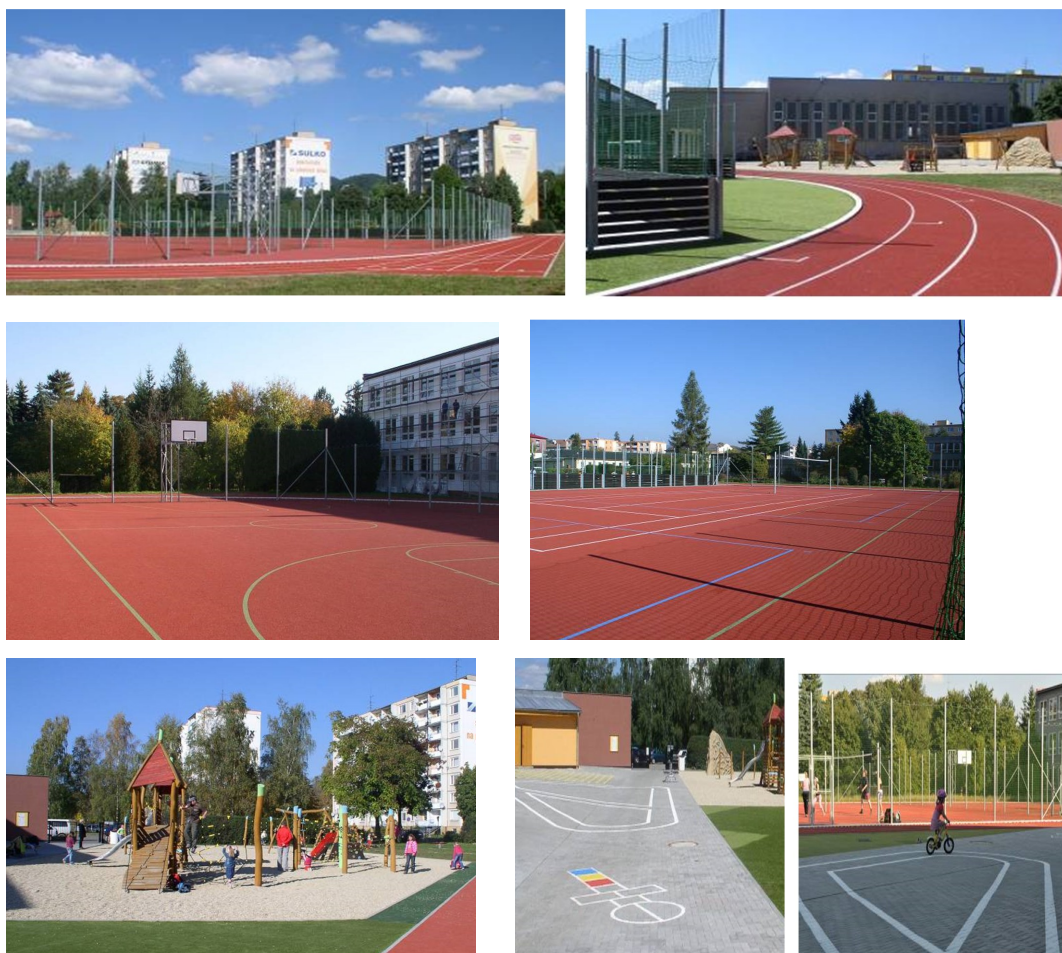
Obrázek č. 11: Zrekonstruované hřiště u ZŠ Šumavská
