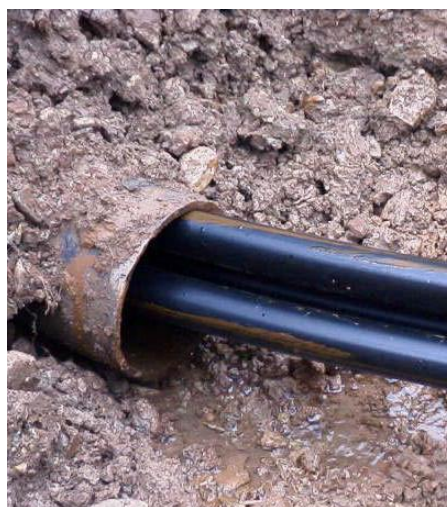
Obr. č. 27 - Sanace potrubí metodou Subline, zdeformovaná vložka a vyrovnaná vložka
