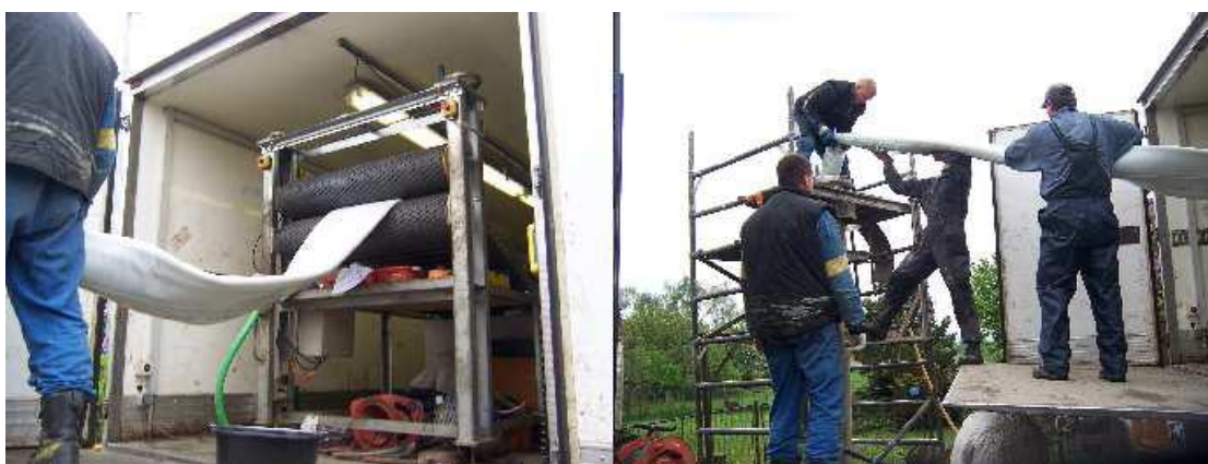
Obr. č. 41 - Vytahování rukávce přes kalibrační válce a jeho zavádění do stoky.
