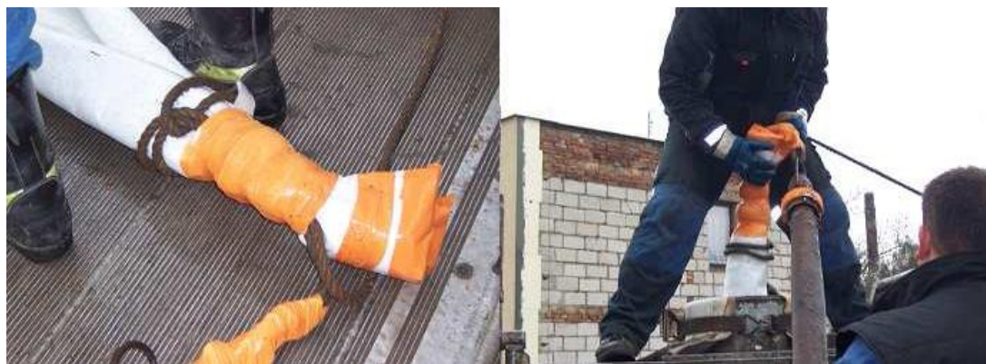
Obr. č. 44 - Zapouštění konce rukávce a jeho zajištění.
