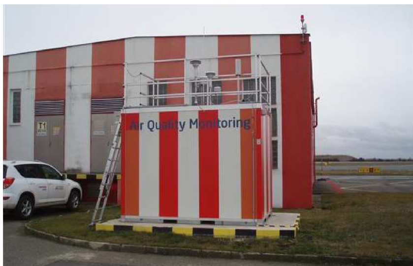
Obrázek 21 - Monitorovací stanice ALERA Letiště Ruzyně (zdroj: www.chmi.cz )
