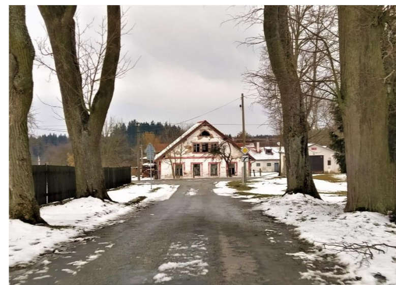
Pohled z cesty (L1) na jednu z budov dříve tvořící hospodářský dvůr (B1)
