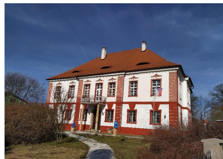
Zámek ve Vilémovicích (B1) - jádro této kompozice
