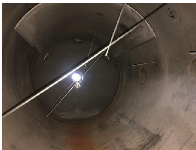
Obr. 37: Pohled do spalovací komory na rozmístění termočlánskových sond
