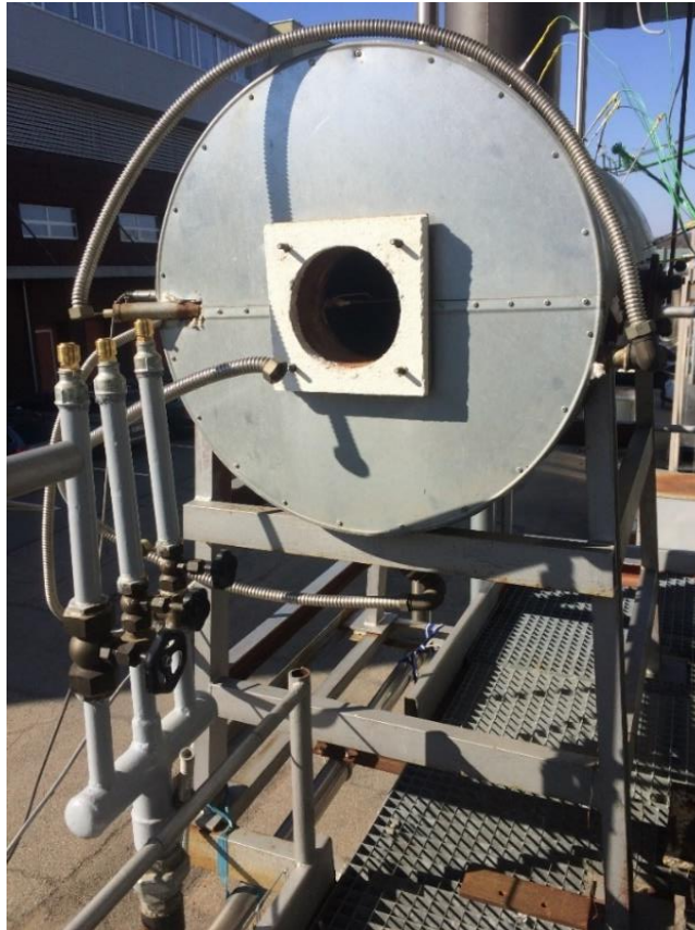
Obr. 38: Komoře po dokončení příprav
