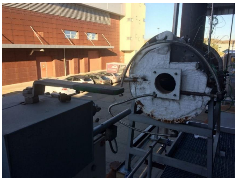
Obr. 30: Stav komory před zahájením prací
