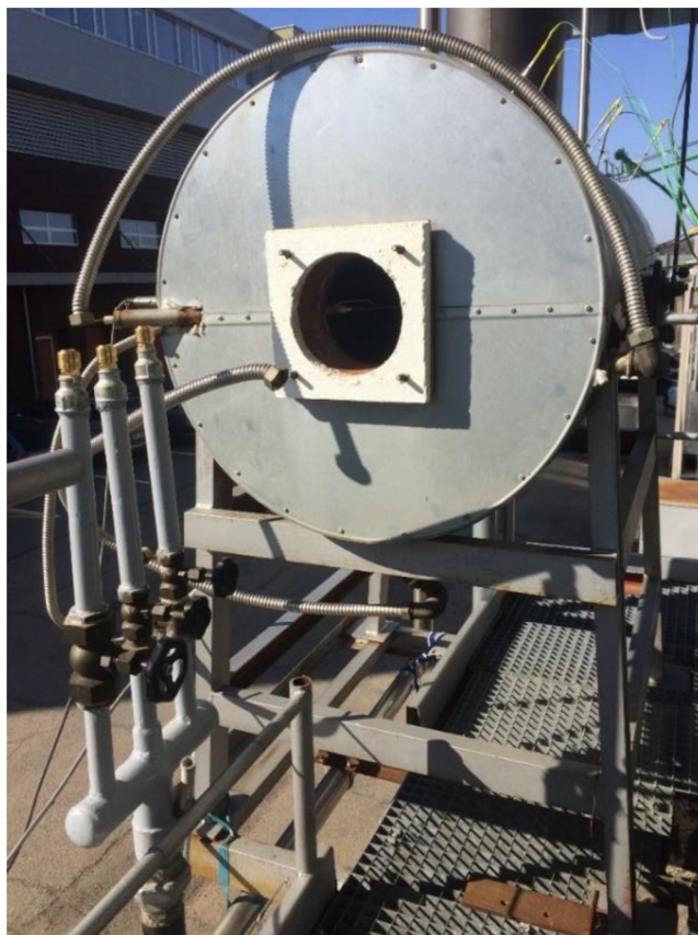
Obr. 38: Komora po dokončení příprav
