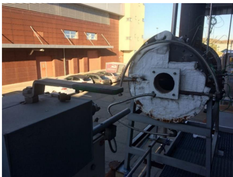
Obr. 30: Stav komory před zahájením prací
