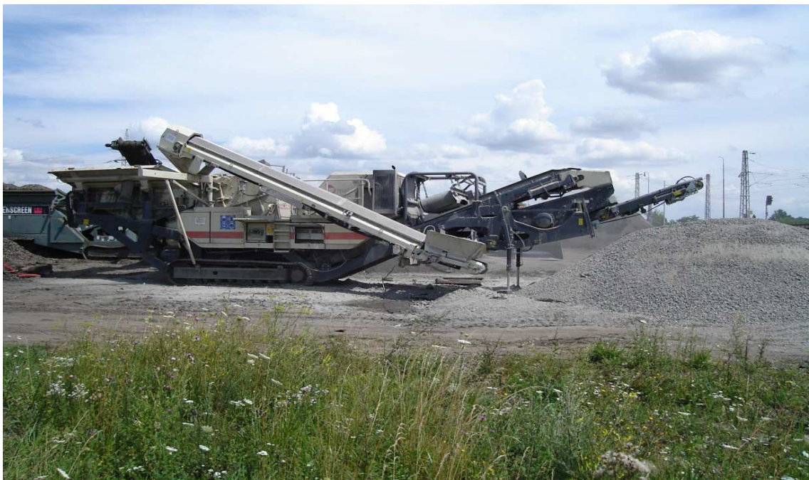
Drťící jednotka na plazech METSO LT 1110S (ŽSD, a.s., interní dokumentace)
