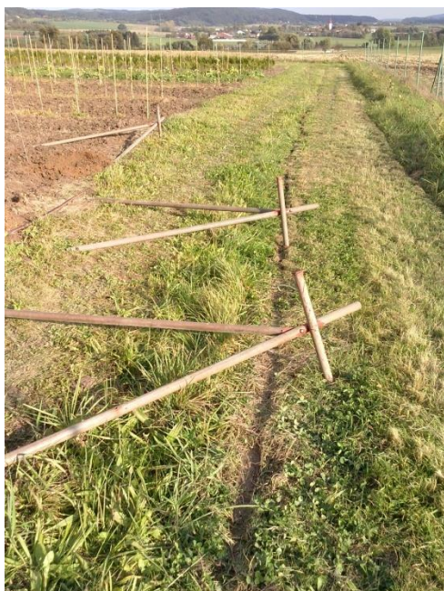
Obrázek č. 2- Realizace opěrné konstrukce, podzim r. 2017
