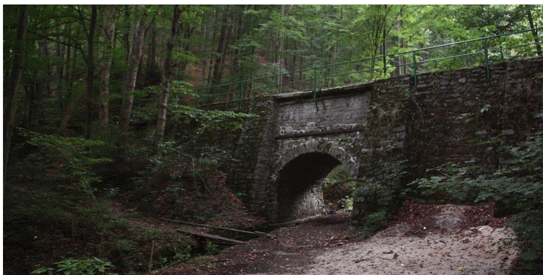
Obrázek 71 – akvadukt Weisshuhnova kanálu nad Kamenným potokem (zdroj. P. Satke)
