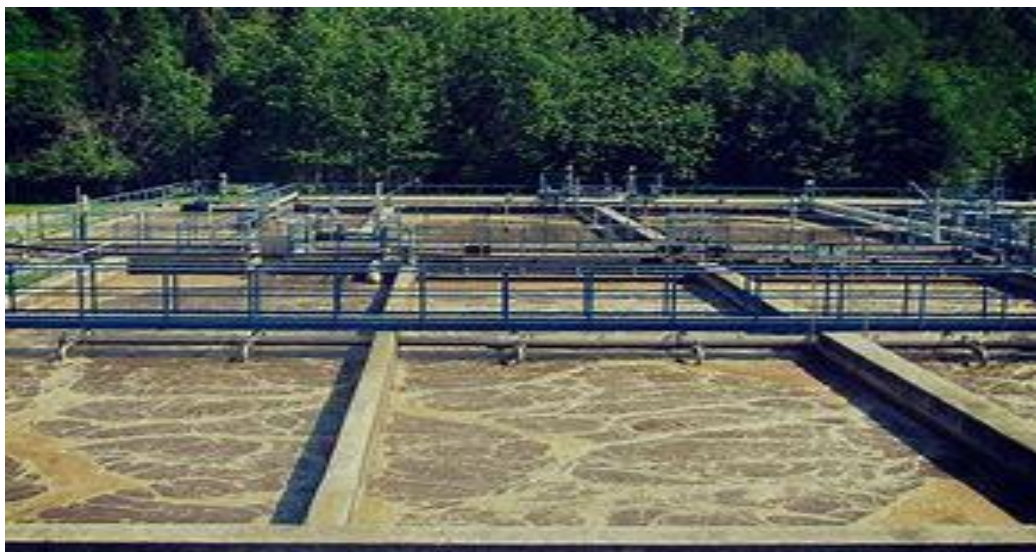
Obrázek 3 - Čistírna odpadních vod (Vodárenství.cz)
