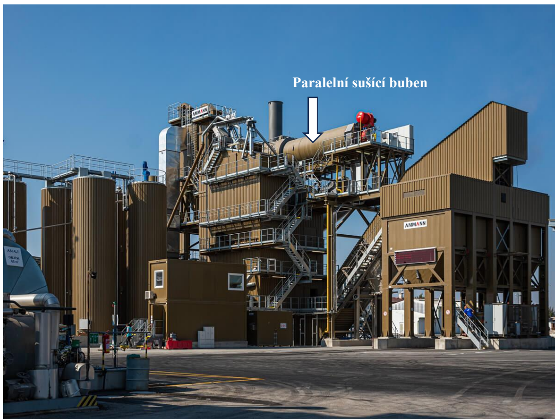
Obrázek č. 11: Obalovna s paralelním bubnem, Česká republika – Praha [41]
