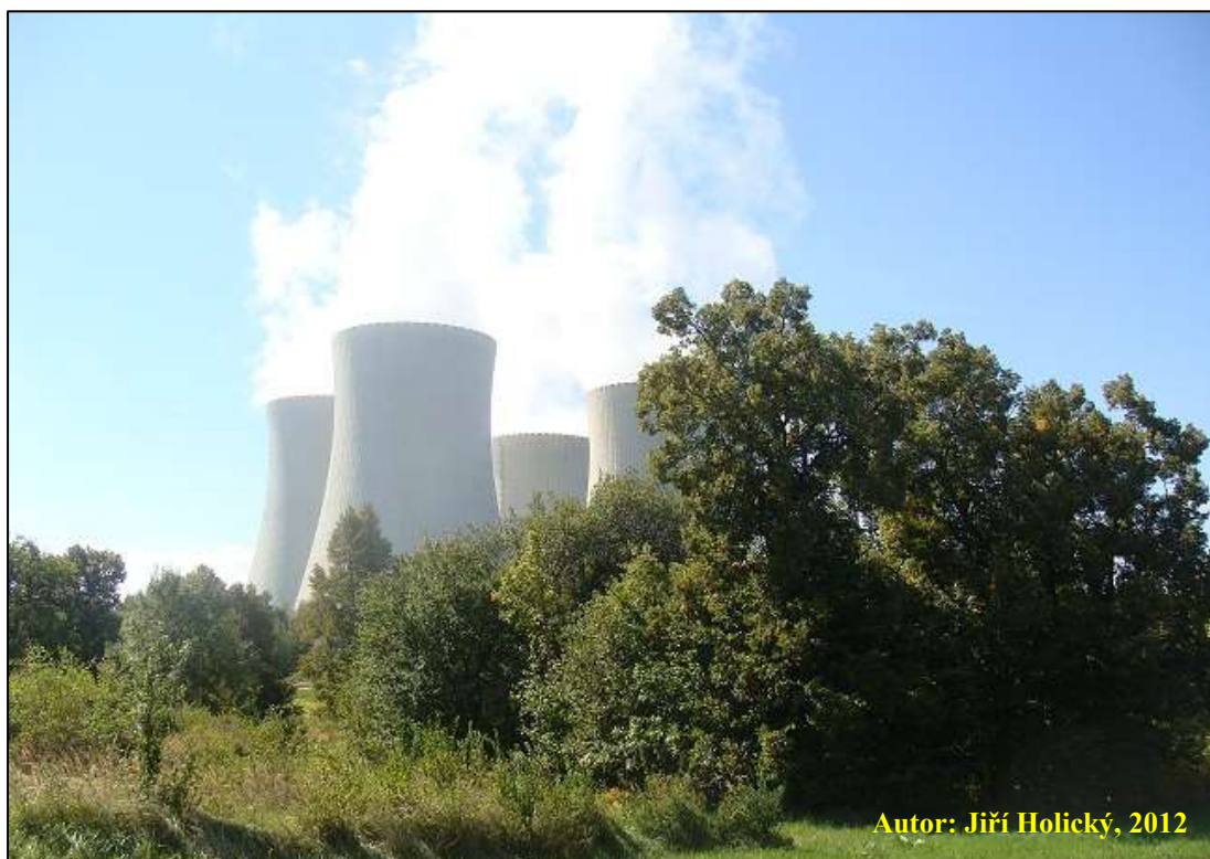
Obrázek č. 8 – IP 7 (Březí u Týna nad Vltavou) pohled k JETE
